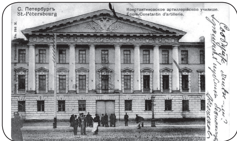
Здание Константиновского артиллерийского училища. Санкт-Петербург.
