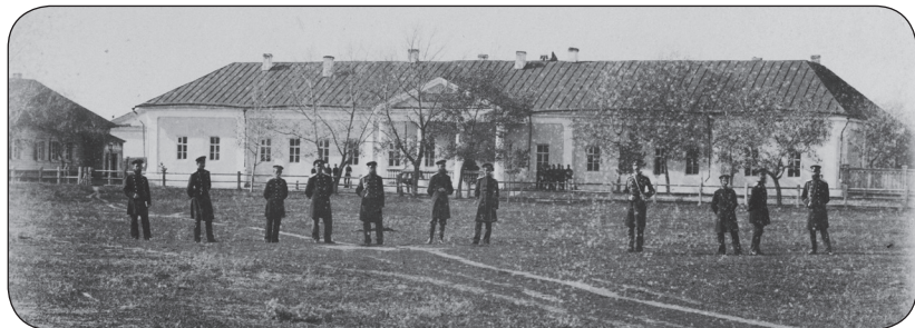
Здание Омского военно-окружного штаба (построено в 1792 г., утрачено в 1970-х гг., восстановлено в 1997 г.). Конец XIX в. Из фондов Омского государственного историко-краеведческого музея The building of the Omsk Military District Staff (built in 1792, destroyed in 1970s, restored in 1997). Late 19th century. From the fonds of the Omsk State Museum of Local History
